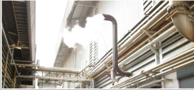
ภาพ ก่อนการติดตั้งระบบ EVC Heat Exchanger
