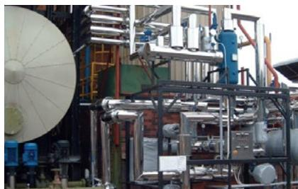
Рекуперация тепла пара вторичного вскипания на мясном производстве
