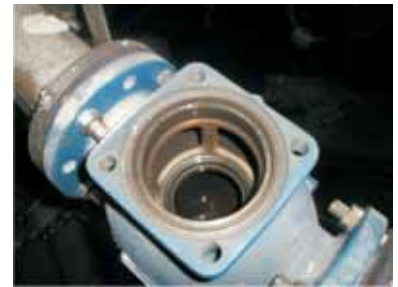
Рисунок 4. С клапана снята крышка и привод
