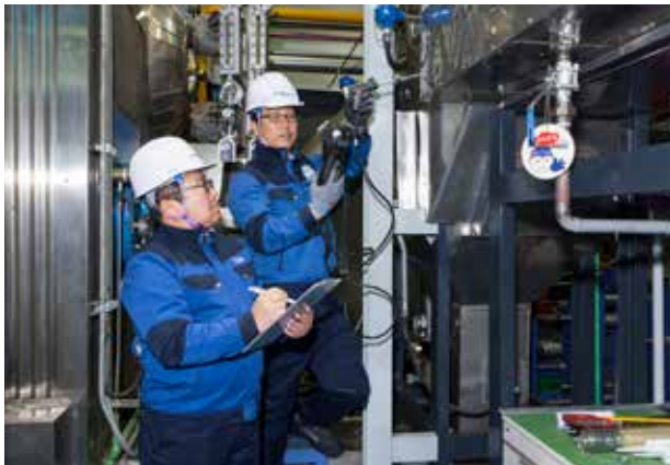
그림 2. 한국스파이렉스사코 Engineered Systems & Solution 사업부 현장 진단
