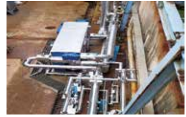
흡수식 냉동기 설치
