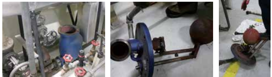
응축수 회수 펌프 분해 정비
