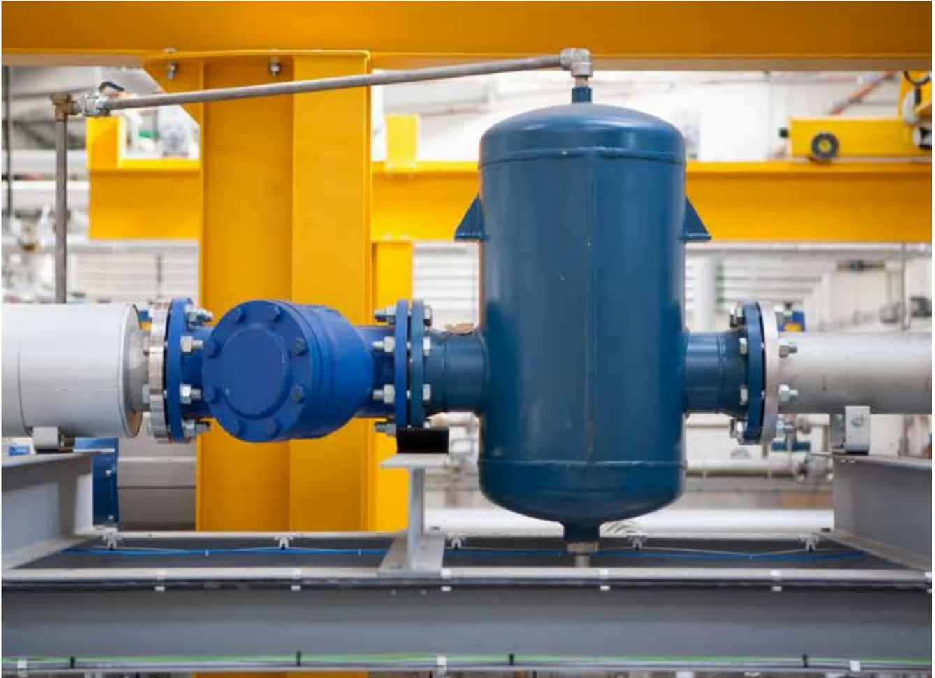
*Dampftrockner steigern die Dampfqualität und sorgen für eine gleichbleibende Effizienz bei der Wärmeübertragung.*
