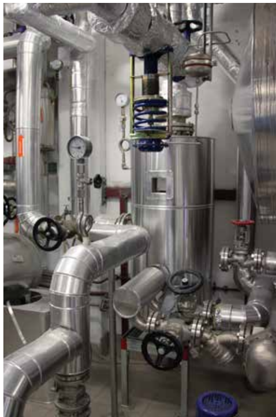
Kondensatentspanner mit Druckhalteventil und Überströmregler
