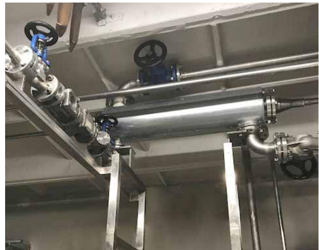
Der Turflow EVC von Spirax Sarco sorgt nun dafür, dass die Energie aus dem Nachdampf rückgewonnen wird.
