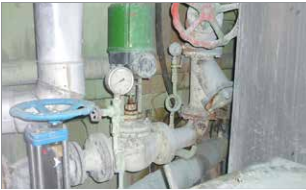
▲ Abb. 1: Sichtbare Folgen mangelnder Entwässerung
