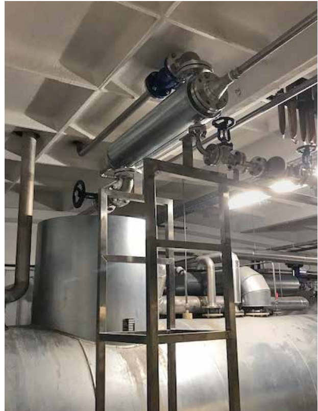
Der Turflow EVC von Spirax Sarco sorgt nun dafür, dass die Energie aus dem Nachdampf rückgewonnen wird.
