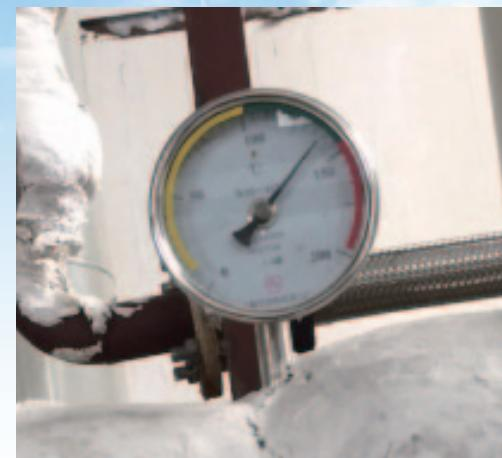
进入低压管网再次利用的4barg二次蒸汽流量高达970Kg/h，远高于设计理论值，说明车间疏水系统的疏水阀或旁通存在泄漏情况，我们下一步将实施检测改善。水箱排放管已无废气排出。
