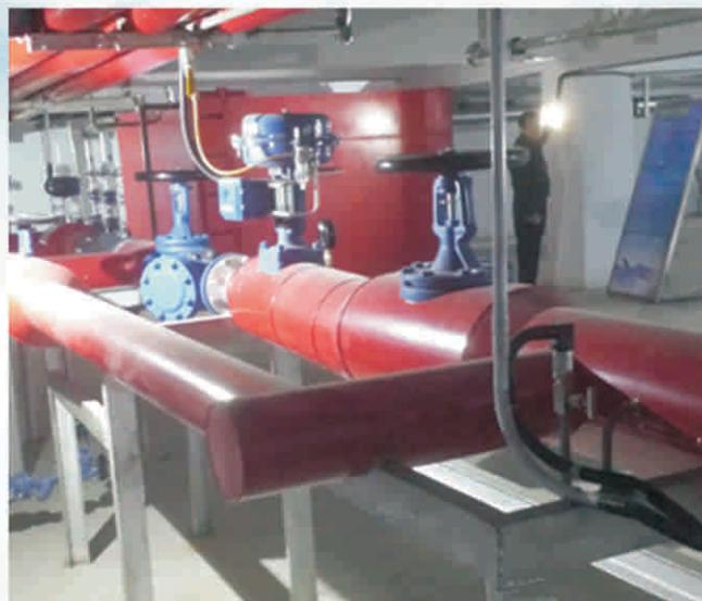
根据生产二部2010年和2011年两年的疫苗产量、蒸汽用量、使用原减压系统及改造后单位能耗这四项对比，计算得出每年可节省蒸汽1248吨，按照我厂2011年成本核算费用得知，蒸汽每吨成本115元，再加上更换2个国产DN150减压阀的费用1万元，共计节约费用 $1248 \times 115 + 10000 = 153520$ 元。本年度改造这套减压系统共计花费近10万元，不到一年的时间我们就收回了投资成本。具体产量及蒸汽用量见下图：
