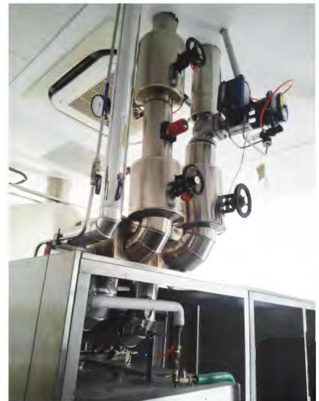
整套阀组安装调试之后，我们将压力设定在2.7barg。现在灭菌柜的使用过程中洁净蒸汽的压力始终控制在2.5barg-2.9barg之间，满足我们的使用要求。改造之后再没有出现过由于蒸汽超压而造成的灭菌失败。
