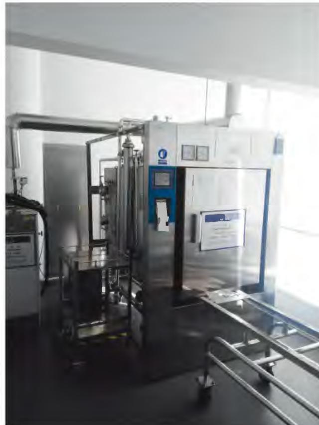
原灭菌柜蒸汽系统使用一台电加热蒸汽发生器为其提供灭菌用蒸汽。现在此灭菌柜内壁已经出现结垢和内壁腐蚀的情况。我们总结原来的蒸汽使用经验，在新建消毒中心时使用了一台斯派莎克洁净蒸汽发生器为新旧两台灭菌柜供应灭菌用蒸汽。此洁净蒸汽发生器（下图）使用园区工业蒸汽作为热源加热RO水，产生洁净蒸汽，供两台灭菌柜使用。
