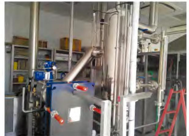
初始安装时，洁净蒸汽发生器与2台灭菌柜放置于一个房间内，洁净蒸汽压力设定为2.8barg。刚开始启用时，我们发现其洁净蒸汽出现压力超高的情况（超过灭菌柜设定的最高蒸汽压力3barg），会导致整个灭菌过程失败。我们约了斯派莎克工程师对现场进行走访。结果发现从洁净蒸汽发生器的分离罐蒸汽出口到灭菌柜蒸汽进口只有不到5米的距离。在灭菌柜工作过程中，蒸汽进汽和真空泵抽汽在预热和排气的过程交替进行。由于灭菌柜使用的开关阀都为快速开启的气动角阀或电磁阀，这就导致了蒸汽在进汽的过程中会频繁的被切断和打开，造成洁净蒸汽发生器在调节洁净蒸汽的产生过程中无缓冲时间，且容易瞬间超压或瞬间压力过低。
