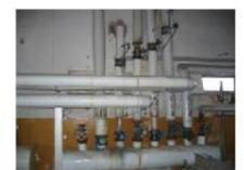
问题5：主蒸汽管道的截止阀，蒸汽输送管道的减压站，蒸汽分汽缸的截止阀大都未进行保温。
