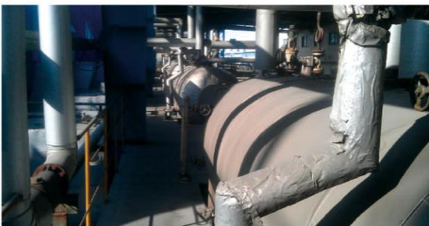
改造完成后，我们检查了汽水分离器下疏水阀的排水，发现确实有较多的冷凝水被排除，蒸汽的品质得到了较大的提升。
