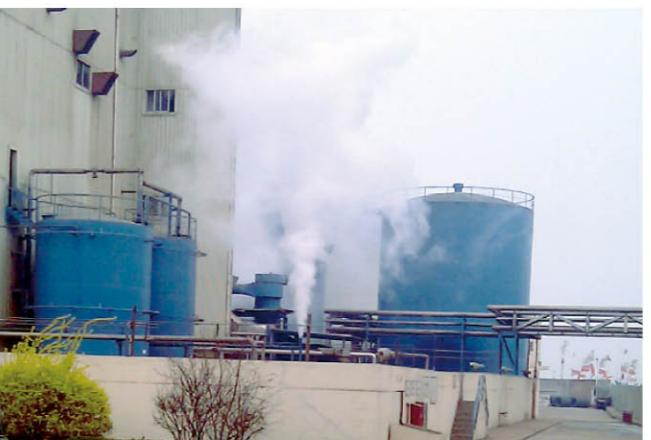
假如一个中型的大豆浸出厂，以2000吨/天的加工量计算，浸出车间10barg的饱和间接蒸汽用量约为9T/H，按照上述计算，则逃逸浪费的闪蒸汽的量为 $9 \times 0.16 = 1.44\text{t}/\text{H}$ ，现在一般链条锅炉蒸汽成本约为160元/T，如果按照每天24小时连续运行，一年300个工作日，则每年逃逸浪费的蒸汽 $1.44 \times 24 \times 300 = 10368\text{t}$ ，约合人民币1658880元。考虑到热量损失的不可避免性，在上述数字上做0.5的系数，则每年逃逸浪费的闪蒸汽价值也在80万元以上。
