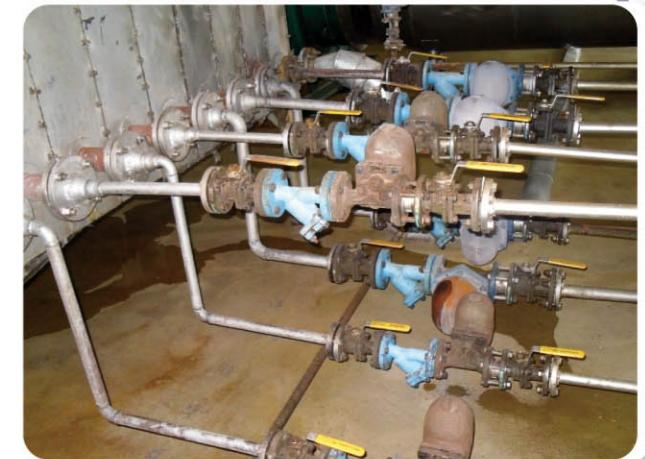
随后斯派莎克提出了相应的解决方案，即每一片加热器片单独安装疏水阀组，独立运行，没有相互干扰，而且根据冷凝率的不同，可以给前面的加热片选口径较大的疏水器，后面的加热器选择口径较小疏水器。较原有的两个超大口径疏水器，投入成本并没有增加太多。
