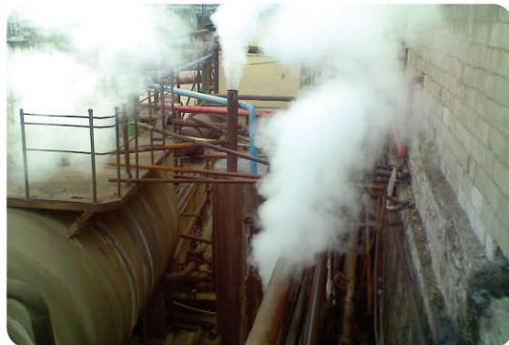
几个回水罐的冷凝水量加起来大约有200t/天，以闪蒸率9%计算，闪蒸汽的量大约有18t/天左右。
