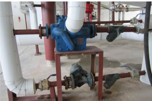
上述新的设计在云县新厂投入使用后，其冷凝水的排放和回收效果一直都非常良好，三大锅和CIP换热器升温快，温度控制稳定，没有水锤的现象出现，现场也没有采用开式回收系统时排空管冒出的烦人的“白汽”。
