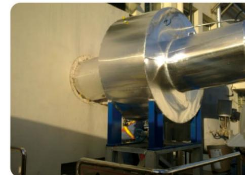
据烟气温度及锅炉给水温度的检测，基本达到设计效果。通过实际检测，节能效果约为4%。
