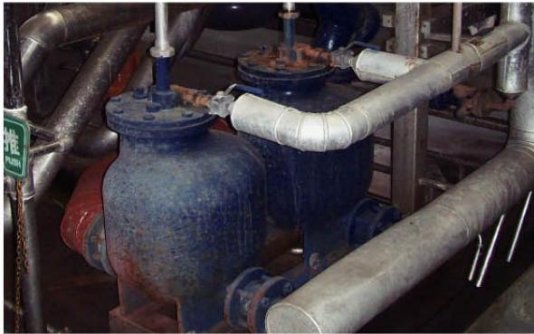
通常，出于节能的考虑，我们会将CIP换热器的冷凝水回收利用。由于冷凝水回收提高了疏水阀后背压，同时由于蒸汽控制阀的节流，会导致“失流”，出现控制阀震荡，换热器内部水锤等现象。我公司改造前水锤曾将一列管加热器打坏，造成酿造车间的很大损失。为了解决这一问题，我们采用了斯派莎克的MFP14机械式冷凝水回收泵，利用外部动力将冷凝水回收。既保证换热器的正常工作，又能回收冷凝水，节约能源。
