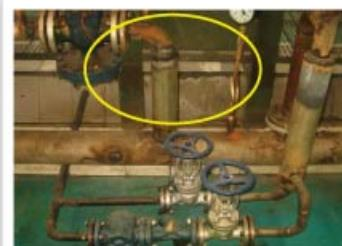
25P减压阀后蒸汽管道改造后,口径为DN80
