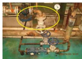
25P减压阀后蒸汽管道未改造前,口径为DN40
