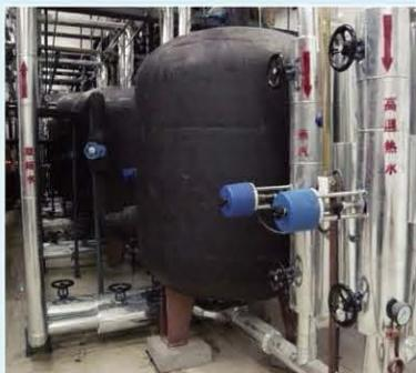
热水，其自备的蒸汽锅炉主要用于洗衣房和客房的干蒸汽加湿及市政热水停止供热时的空调供暖和生活热水的补充等，这样就产生了项目中的换热设备需要分别使用热水和蒸汽两种不同的加热热媒问题，客户原先的方案是作为换热设备热媒的热水和蒸汽共用一条管路和一套控制系统，斯派莎克工程师发现这一问题后及时与客户沟通，告知客户系统这样做会带来问题：蒸汽与水属于两种不同的物质，物理状态、比容、在管路中允许的流速等等都不相同，因此对他们的控制也是完全不同的，如果蒸汽和水共用一套系统控制，会使控制系统不稳定，并造成故障，降低系统的使用寿命。
