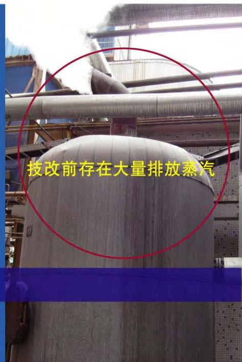
**摘要：**UG-90/5.3-M锅炉和JG-45/5.3-M锅炉，这两台锅炉的连续排污和定期排污都是通过排污扩容对空排放，以及大量100℃以上的连排水通过排地沟排掉，造成了很大的能源浪费与环境的热污染。使用斯派莎克公司提供的板壳式<sup>®</sup>换热器对此排污闪蒸汽进行热回收，预热锅炉除氧给水，每年节约费用约70万。
