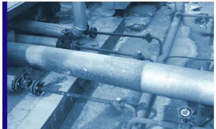
图1 现场疏水阀安装图
