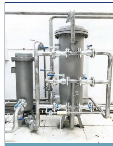
斯派莎克冷凝水除铁装置
