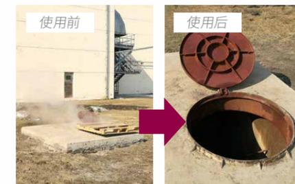
这样的效果让我们立即决定将谷物区域也进行引射器系统的改造，计算下来这一区域闪蒸汽量更大，效果也更明显。2018年11月，谷物区域引射器系统调试完成投入使用，闪蒸汽排放情况对比见下图：
