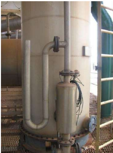
Figura 17 – Proteção contra vácuo utilizando um sifão
