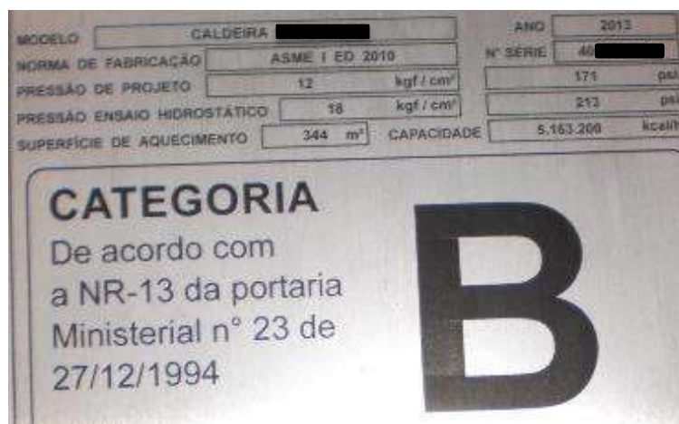
Figura 20 – Foto de placa de caldeira e Categoria da caldeira (Fonte do autor)
