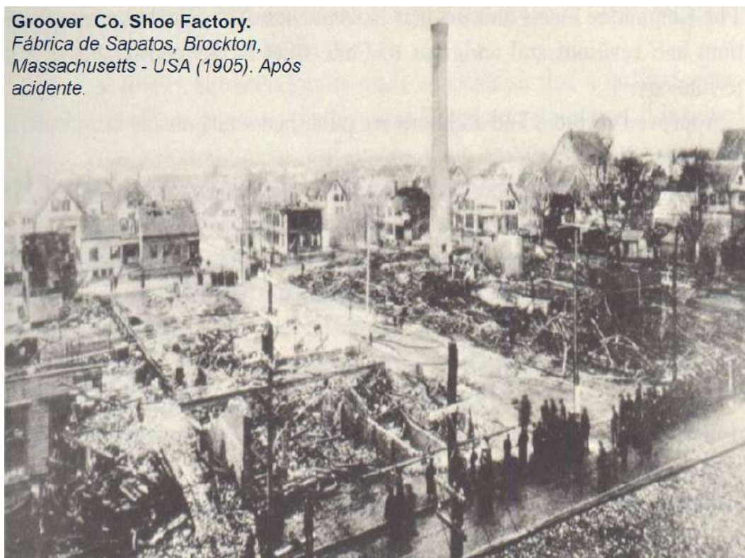
Figura 02 – Fábrica de sapatos Brockton após a explosão da caldeira (1905)
