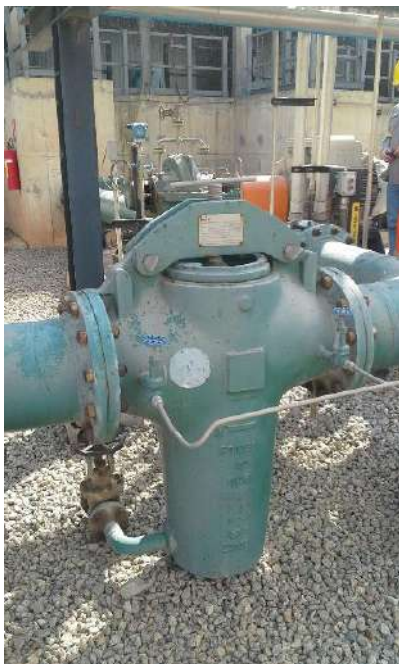
Figura 13 – Filtros que são elementos de tubulação
