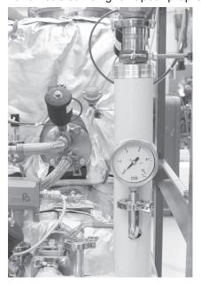
Manomètre sur la ligne pression eau stérilisée
