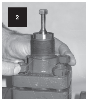
Utáhněte prsty rovnoměrně vždy pár protilehlých šroubů.
